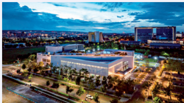
「質子治療中心」全棟採用低碳建材、循環材料、建築節能設計與能源監控系統，搭配雨水回收與智慧節能系統，從能源、水資源管理到資訊安全、建築維運管理，皆依循國際標準進行驗證，堪稱淨零碳排醫療建築的標竿案例。
